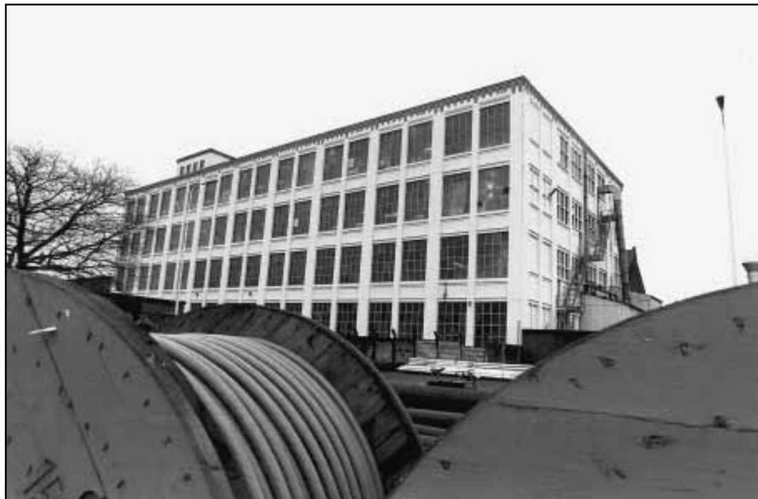
De fabriek van Picus van architect Beltman die op de nominatie staat om gesloopt te worden. Het was één van de eerste panden in Eindhoven van gewapend beton, nog voor de Witte Dame. Foto: Bram Saeys
