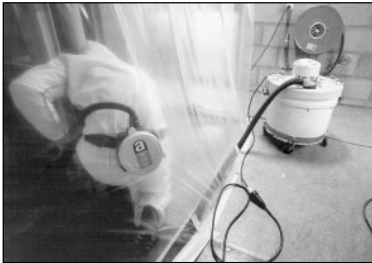
Een in een beschermend pak gehulde medewerker van een speciaal bedrijf is bezig met het verwijderen van asbest in het CTD-gebouw. Foto: Bram Saeys
