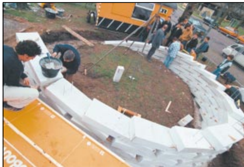
De 'poort' van gasbetonblokken, die al geruime tijd voor het hoofdgebouw staat, is langzamerhand een bekend oriëntatiepunt op het TUE-terrein geworden. Momenteel wordt een opvolger geconstrueerd tegenover de toekomstige containergebouwen van TNO bij T-hoog. Dit ontwerp wordt door een P-onderwijsgroep van de faculteit Bouwkunde opgebouwd en is van de hand van Rosita Steltenpool. De 'krul' is bedoeld als hangplek waarbinnen studenten elkaar kunnen ontmoeten.
